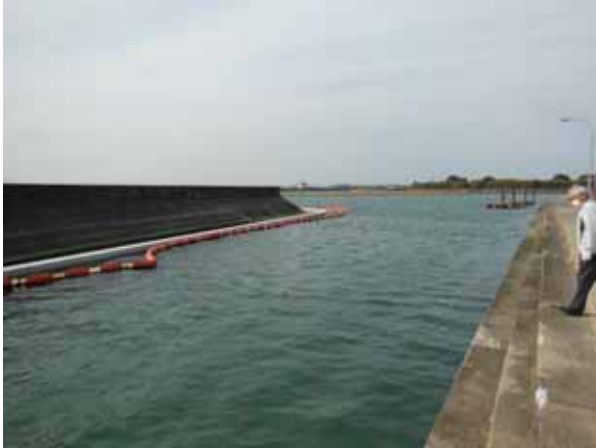
[写真—1 対岸より施工現場を望む]
